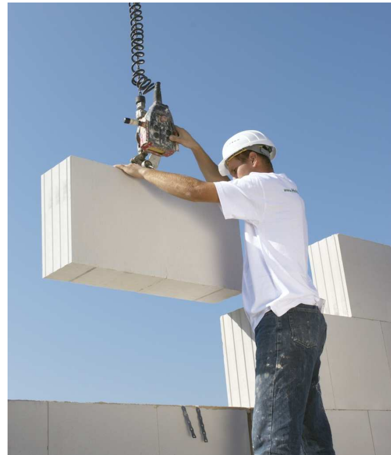
Minijeřáb a uchopovací zařícení s řídící jednotkou
